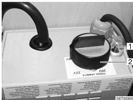
Bild 86 Regler für elektrische Fußbodenheizung
